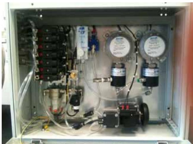
L'Explorer Multipoint è un sistema a scansione multipla pensato per la rilevazione gas in ambienti di difficile accesso. Trova applicazione sia a bordo nave che nel settore Oil&Gas.
